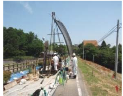
堤体の土質調査
