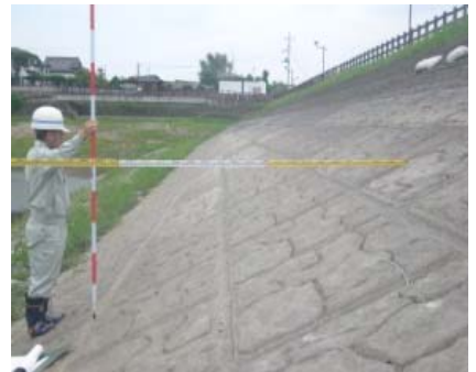
堤体の断面測量
