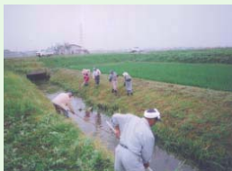
水路の泥上げ
